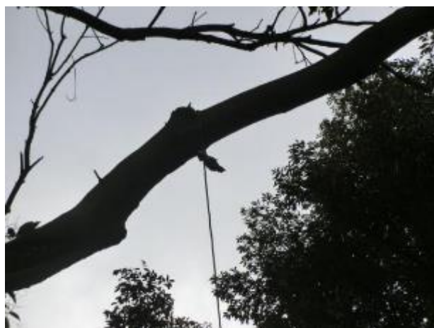
伐倒に障害となる枝にワイヤーを掛け
