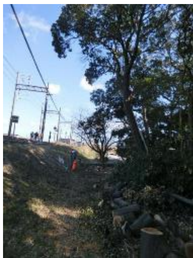
対象木伐倒に障害となる樹を伐採
