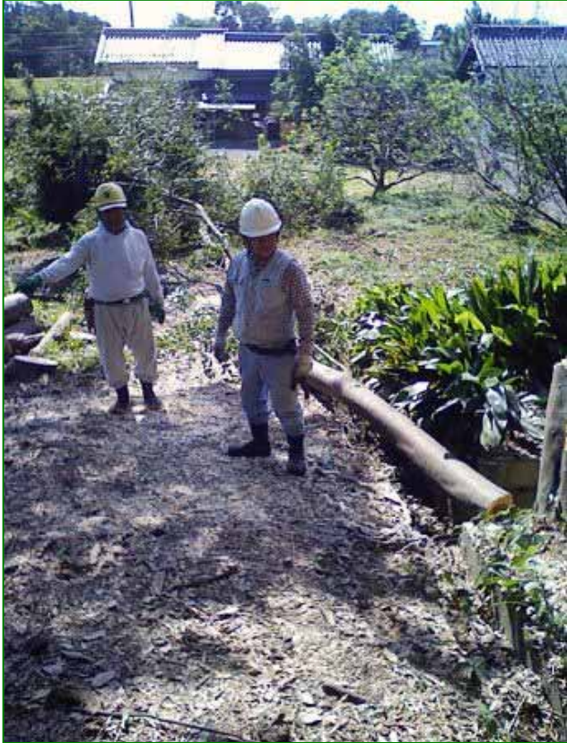
2本目の木、伐倒したところ。これから小切りし片付けます。 狙った場所に倒せましたが、倒れ始めが早過ぎ。
